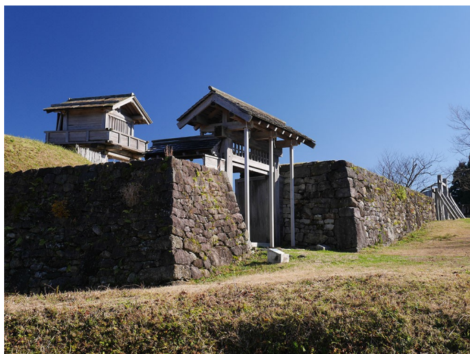
織田方が改修した外柵形虎口に復元された門と石垣
