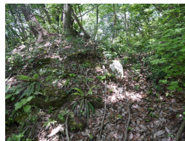
裏込石が未使用の石垣
